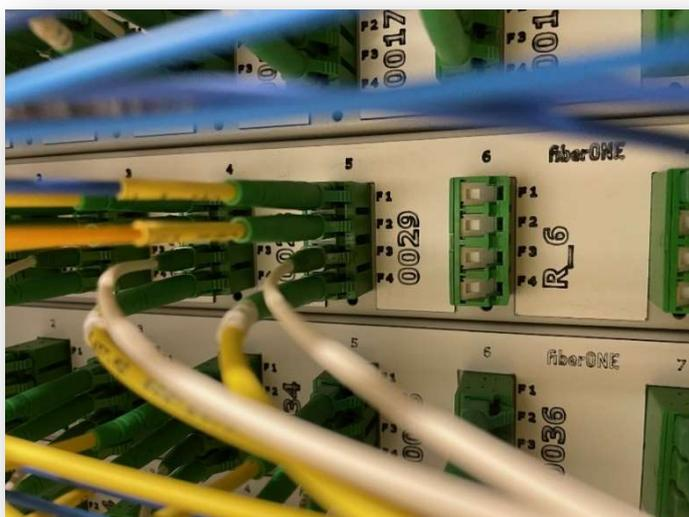
Abbildung 2: Jede WE des in 1 gezeigten Racks wird mit 4 Signalen versorgt: 3 TKU liefern Internet, über die 4. Faser wird ein TV-Signal geliefert.
